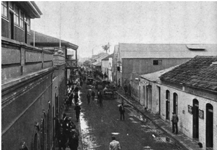
La Rua dos Mercadores, en la zona baja de la ciudad de Lourenço Marques, a finales del siglo XIX.
