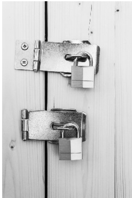
Montaje incorrecto y correcto de un cerrojo. ¿Se ha olvidado las llaves? No hay problema, solo tiene que quitar un par de tornillos y ya está.
