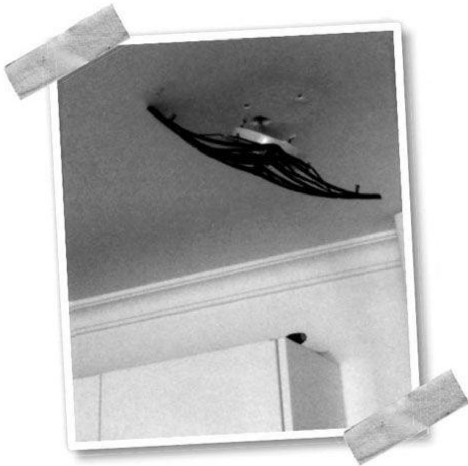
Plafón desprendido en el salón del apartamento de Agus. (Foto: Agus Aguirre).
