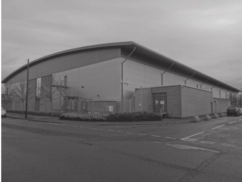
Centro de datos LD4, Slough. Fotografía: James Bridle.
