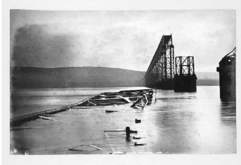
La destrucción del puente sobre el Tay, en Escocia.
