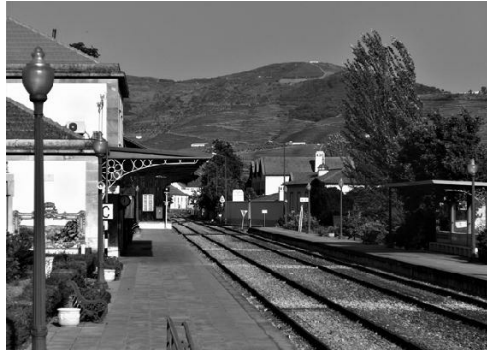
Estación de ferrocarril de Pinhão
