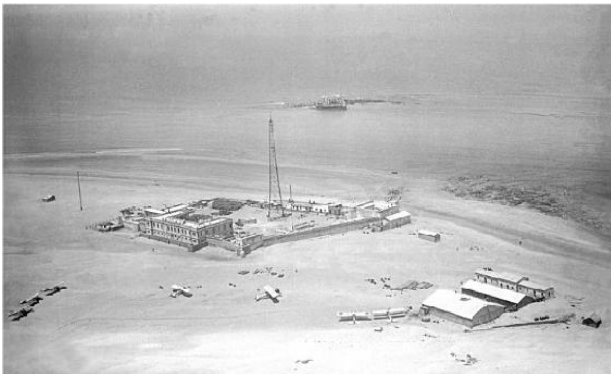
Aeródromo de Cabo Juby en vista oblicua en placa sin fechar pero cuya nueva torre de comunicaciones, que destaca, permite establecer la fecha entre 1934 y 1936. (Foto Ministerio de Defensa, AHEA 1-09211-01.)
