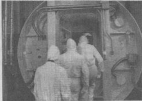
Esta gruesa compuerta separa y aísla la sala del reactor del resto de las instalaciones de la planta. Quienes penetran al núcleo de protección —dentro está el reactor— llevan que vestimenta obligatoria: traje más que traje especial como los que pueden verse en esta fotografía y que fueron utilizados por los periodistas de «La Vanguardia» que visitaron Ascó.
