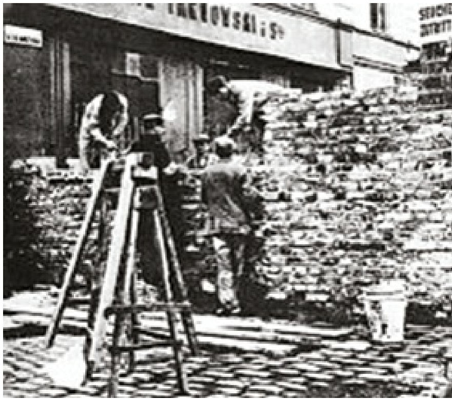
Construcción de uno de los muros del gueto de Varsovia por los propios judíos en agosto de 1940.
